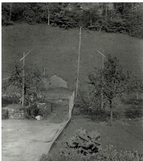
Abbildung 2: Bauprofile für den Neubau
