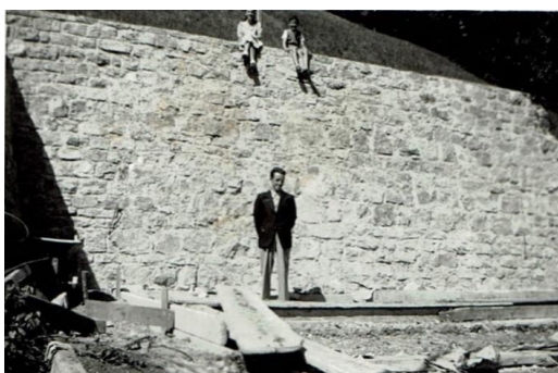
Abbildung 1: Stützmauer als Hangsicherung
